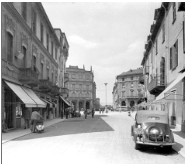
Immagine d'epoca dell'inizio di via Vittorio Emanuele. Sullo sfondo la piazza centrale della città (non esisteva ancora il palazzo dell'Ariston)
