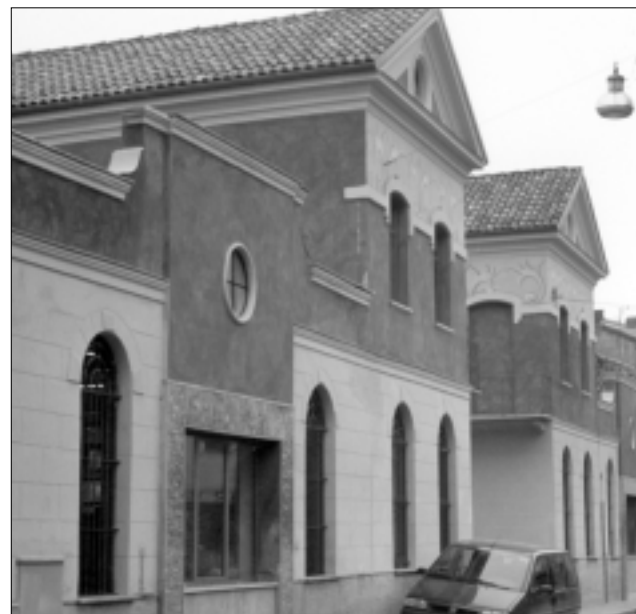
La nuova sede degli uffici delle entrate a Nizza.
