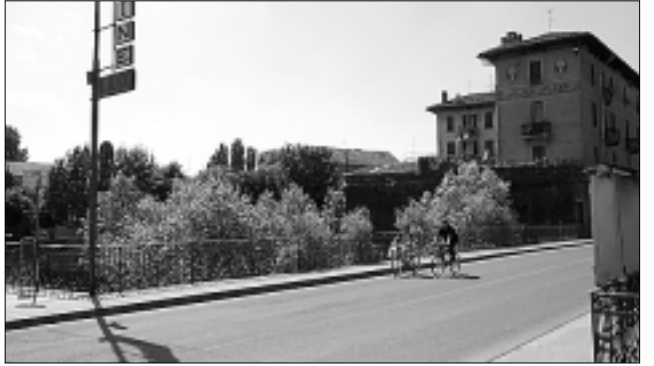
Gli alberi che spuntavano dal ponte.
