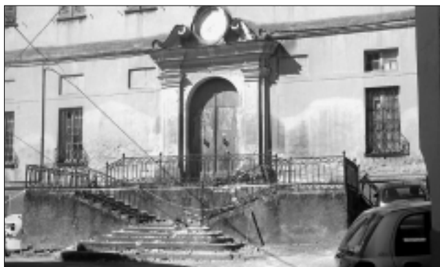
Un crollo parziale a Mombaruzzo.
