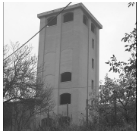
La torre idrica quasi ultimata.
