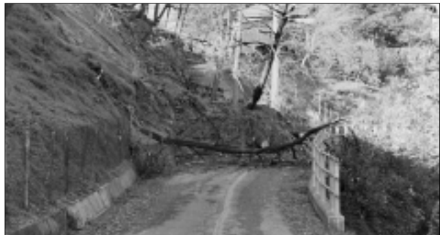
Le frane di Villanuova.
