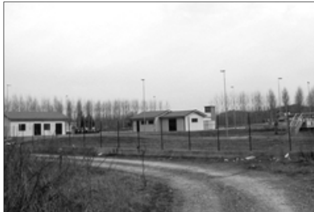
Una veduta dell'impianto di depurazione.
