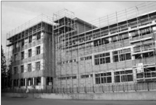
L'impalcatura per i lavori sul tetto dell'istituto nicese.
