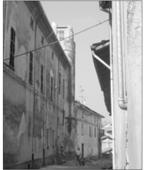
La torre del castello di Bergamasco danneggiata dopo il sisma del 21 agosto scorso.
