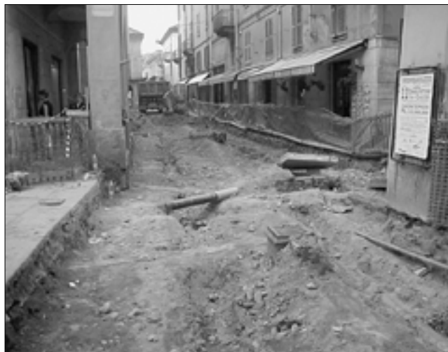
Lavori di pavimentazione di via Carlo Alberto
