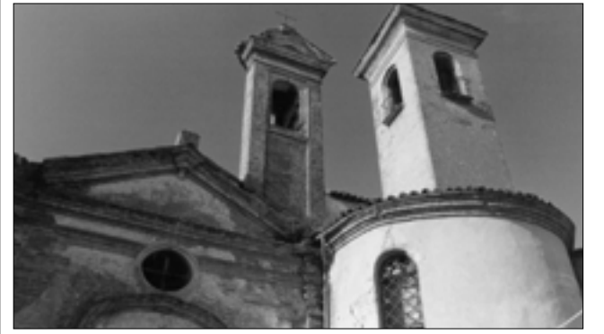
Il complesso di S. Bernardino a Mombaruzzo.
