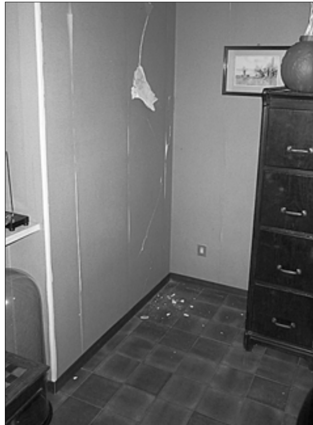
I danni all'interno di una casa di Castelnuovo Belbo.
