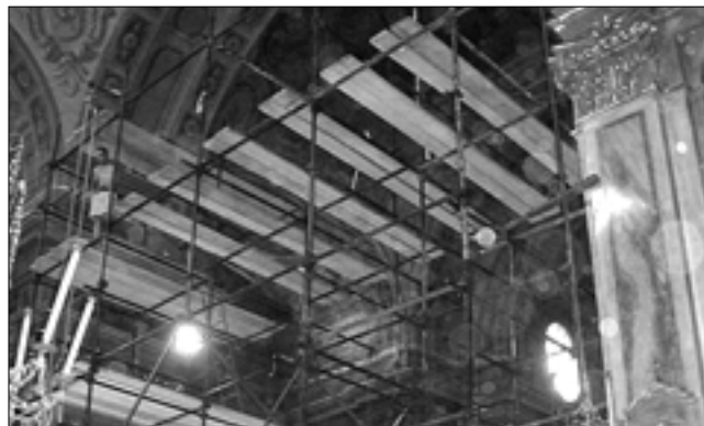
Il ponteggio di sicurezza in fase di montaggio.
