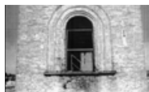
Un particolare del danno al campanon.
