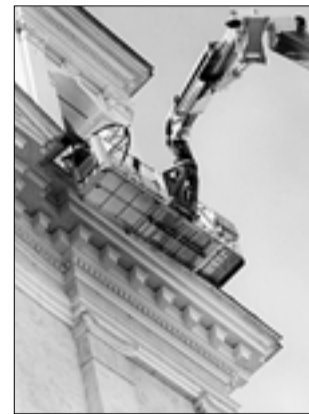
L'intervento alla chiesa parrocchiale.
