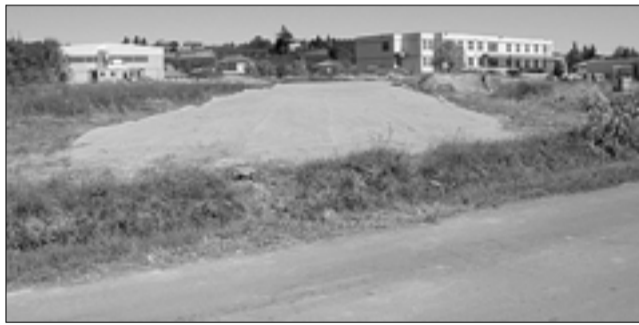
La nuova strada in costruzione.
