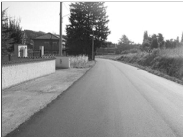
Due tratti della strada provinciale n. 46, riasfaltati nel territorio di Castelnuovo Belbo.
