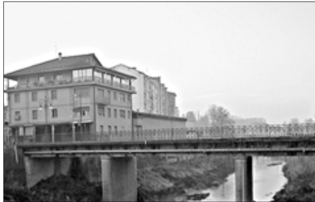
Il ponte Buccelli sul Belbo
