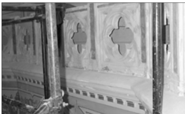
Uno dei cornicioni restaurati.
