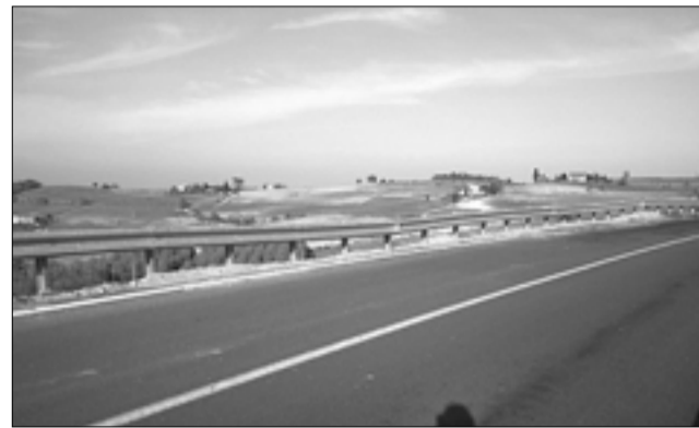
Il tratto in cui la statale sta nuovamente cedendo.
