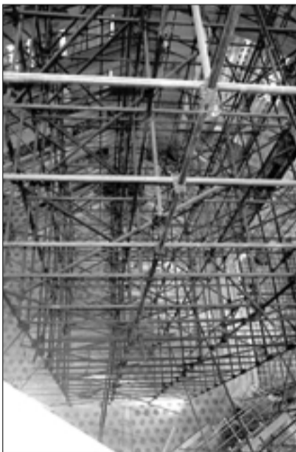
Il ponteggio visto dall'alto in basso.
