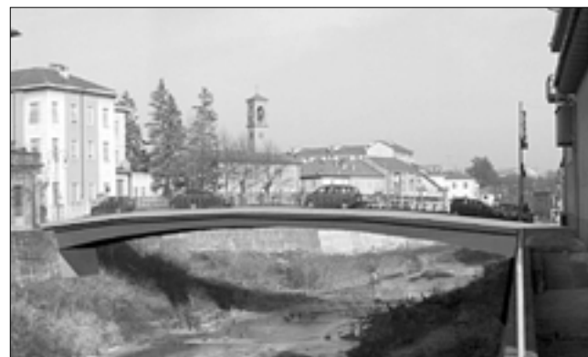
... e l'elaborazione computerizzata del nuovo ponte.
