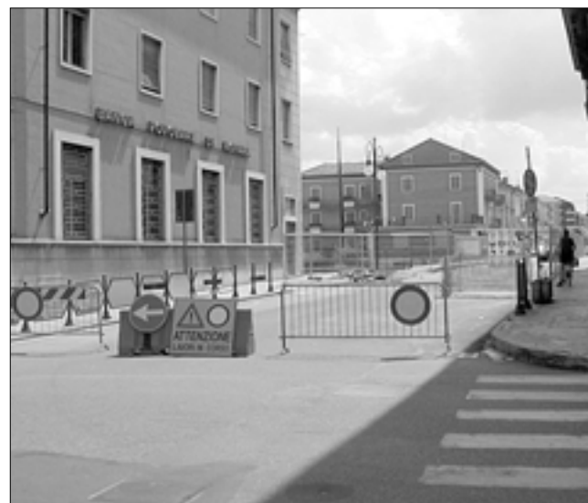
Transenne e lavori sul vecchio ponte...
