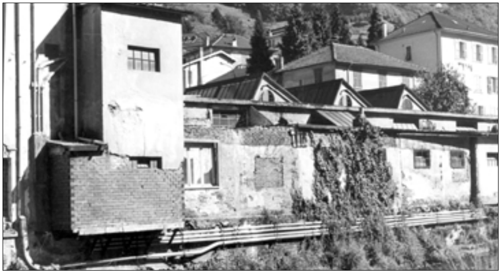
La zona che sarà demolita per far posto ai posteggi
