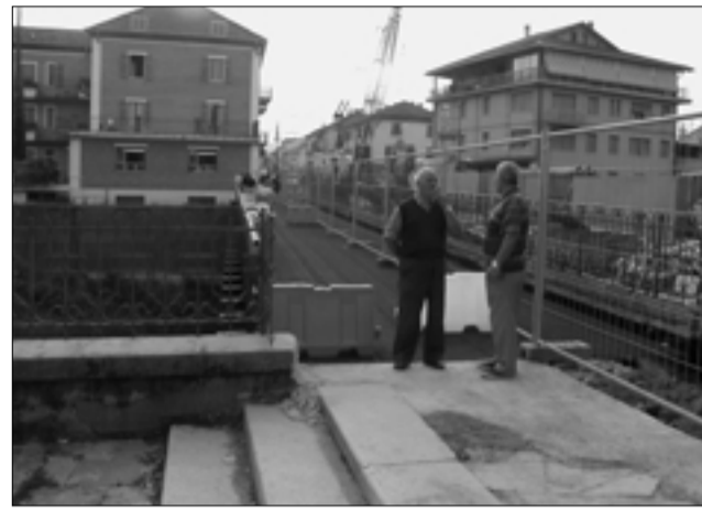
La nuova passerella sul torrente Belbo.
