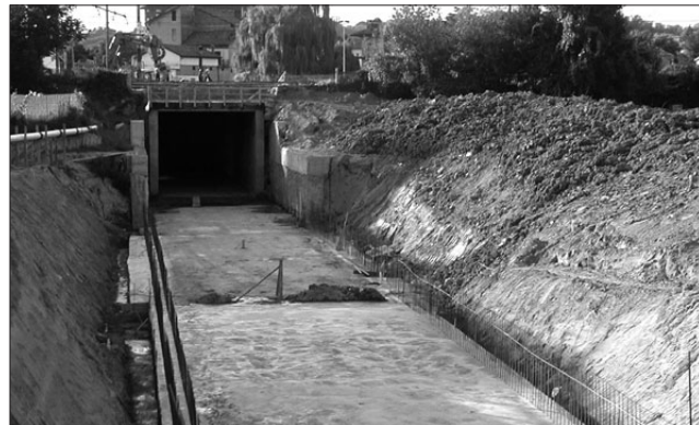
La galleria sotto la ferrovia ed il nuovo letto forzato del rio Nizza.
