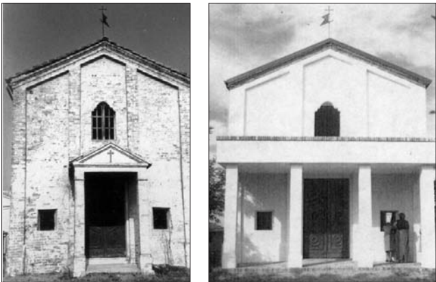
San Rocco a Maranzana prima (a sinistra) e dopo (a destra) il ripristino del porticato.
