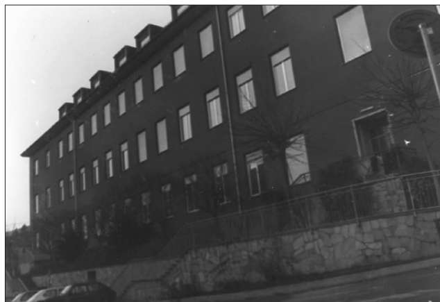
Via Trento di fronte all'edificio scolastico.
