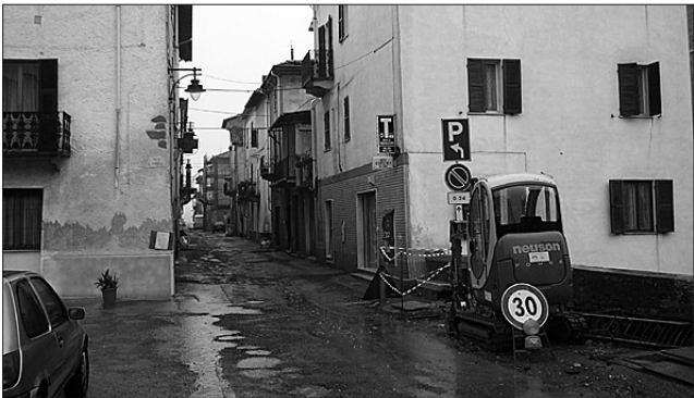
Il cantiere per il rifacimento del manto stradale in via Giovanni XXIII.
