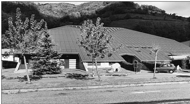
La grande superficie del tetto del palazzetto.
