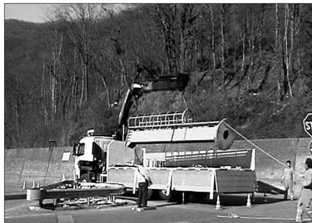
I lavori per la rotatoria sulla strada del Turchino in prossimità dello svincolo autostradale di Masone.
