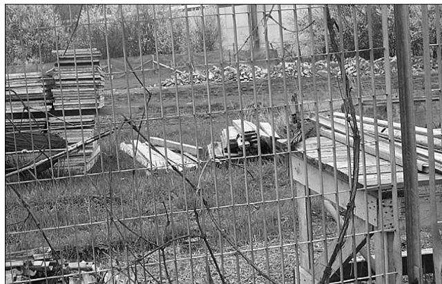
I lavori in corso del polo scolastico.
