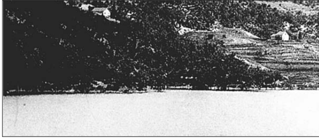
Lago artificiale di Ortiglieto prima del crollo.
