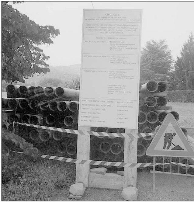
I tubi accatastati per il potenziamento dell'acquedotto Val Bormida.
