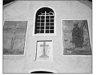
La facciata restaurata.
