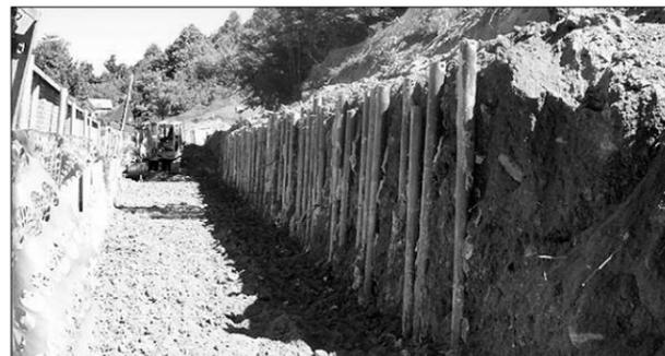
lazione di "micropali": si tratta di tubi di acciaio, conficcati nel terreno molto in profondità (sino a venti metri se necessario) e successivamente riempiti di cemento liquido. Questa struttura è in grado di reggere senza problemi enormi quantità di terra.
