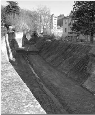
Canelli. È stato ripulito nelle settimane scorse l'alveo completamente cementato di Rio Pozzuolo che arriva dalla collina di San'Antonio e corre parallelamente all'ex ospedale e confluisce nel Belbo. Qui le piante e le erbacce avevano ostruito in parte il letto del Rio creando eventuale pericolo in caso di abbondanti piogge. Un bel lavoro che renderà più sicuro il deflusso delle acque e sicuramente contenti tutti gli abitanti della zona. Nella foto il rio ripulito.
