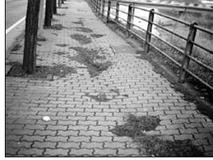
Marciapiede dissestato in via Gramsci.
