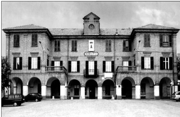
Il palazzo comunale di Castelnuovo Belbo.
