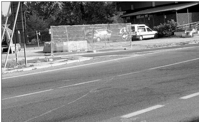
I lavori per la rotatoria.
