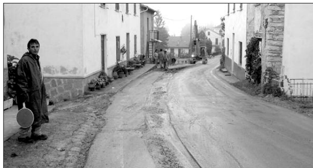
I lavori in località Chippaino.
