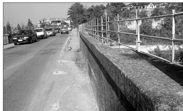
I lavori svolti sul ponte di San Paolo.
