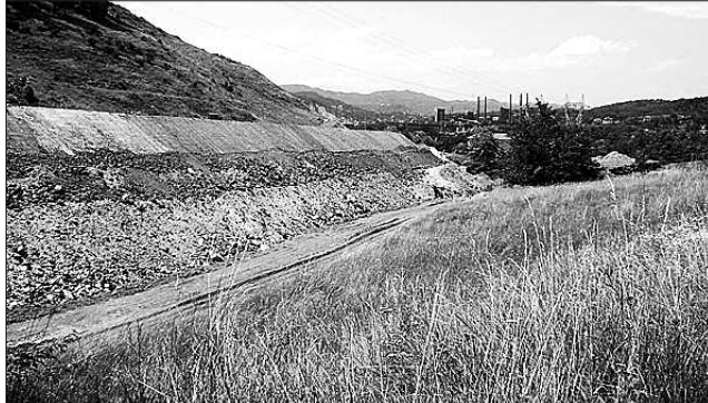
I lavori di sbancamento della variante del Vispa nella vallata a ridosso di Ferrania verso Bragno.
