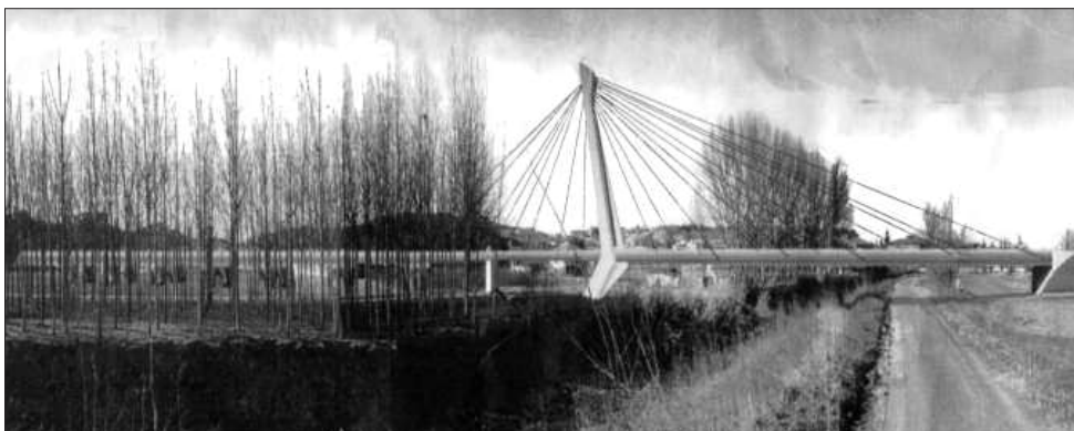
La visione computerizzata del ponte strallato sul torrente Belbo.
