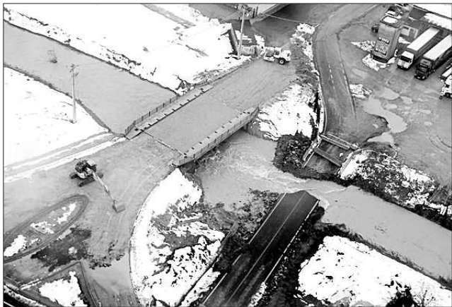
La bocca tarata sulla cassa di espansione sul rio Nizza e il guado sulla strada per S.Marzano demolito per far scorrere le acque.
