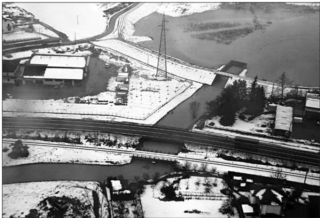
La bocca tarata sulla cassa di espansione sul rio Nizza e il guado sulla strada per S.Marzano demolito per far scorrere le acque.
