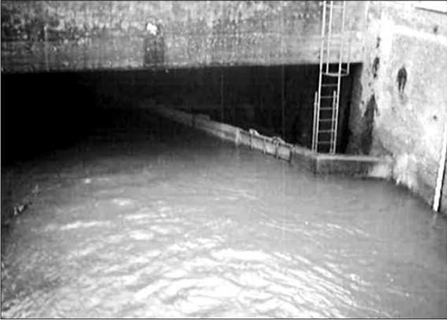
Il rio Nizza all'imboccatura del sifone.
