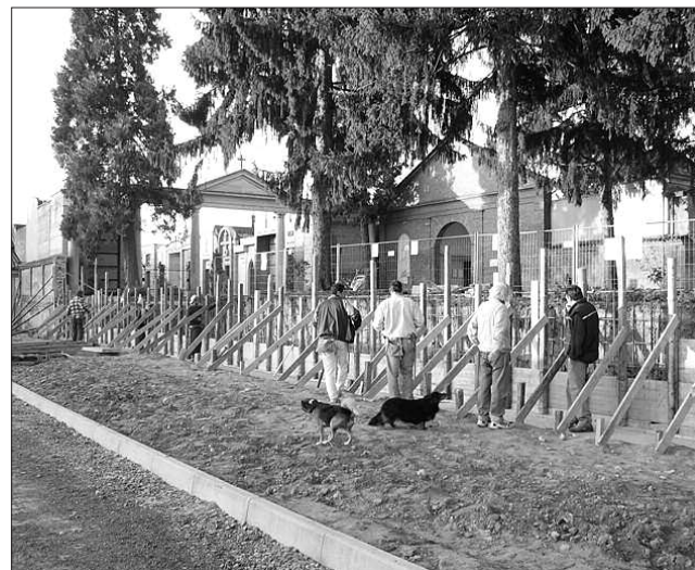
I lavori in corso nell'area d'entrata del cimitero.
