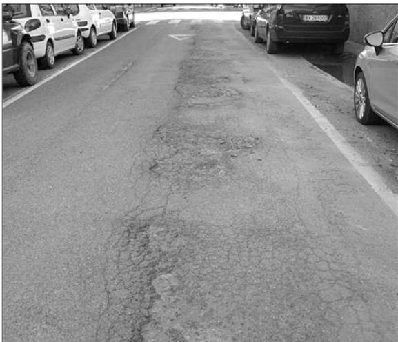
**Ovada.** Nella foto lo stato della sede stradale di via Fiume, nel tratto tra via Cavour e via Siri, alla fine della settimana scorsa. La serie di buche e di avallamenti irregolari è colpa dell'inverno, con annessi (il sale) e connessi (lo spartineve). L'inverno però è finito mentre i conti da gommisti e carrozzieri salgono... L'ultimo tratto della via poi, allo sbocco con via Torino, è pietoso ed inguardabile, anzi impraticabile per biciclette e carrozzelle!
