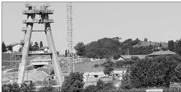
La torre del ponte strallato e, sullo sfondo, la galleria sotto la collina Villalta.
