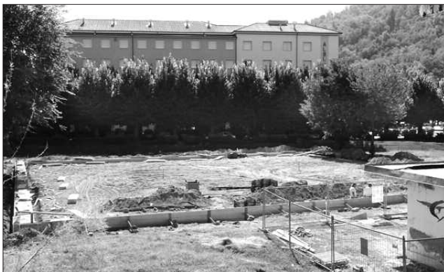
I lavori ai campi da tennis di zona Bagni.
