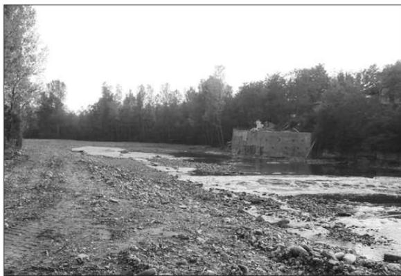
Nelle indicazioni progettuali poi, così come nelle promesse del costruttore, se si dovevano cementare dei massi lo si sarebbe dovuto fare in modo che il cemento non sarebbe stato a vista e limitato a ogni singolo masso. Quelle che è stato fatto invece è un bel basamento comune che adesso appare in bella vista fino a metà del torrente. Non doveva essere una briglia ma una serie di massi di cemento in un unico basamento, per l'altra metà ... solo interrati.
