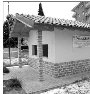
La Casetta dell'Acqua.
