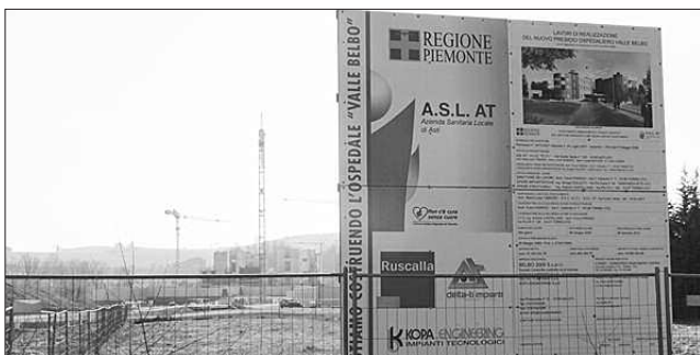
Il cantiere del nuovo ospedale.
