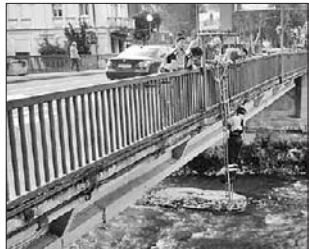
Lo spettacolare intervento di riparazione del tubo dell'acqua.
