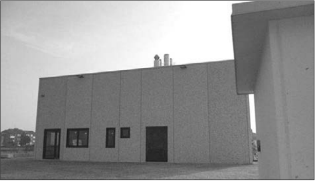
La “centrale” di via Fitteria.
