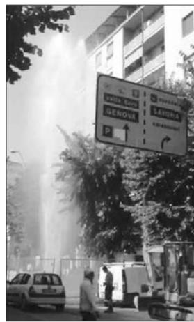
**Durante i lavori per la posa delle tubature del teleriscaldamento agli inizi di agosto è stata rotta una conduttura dell'acqua potabile ed un getto alto una trentina di metri ha stupito i passanti.**
