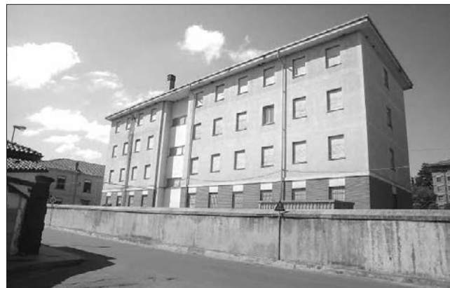
300 mila euro per adattare l'ex dormitorio delle Ferrovie in via Marengo a emergenze abitative.
