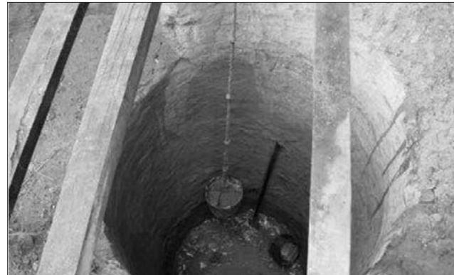
Il pozzo realizzato a Sokpontà
