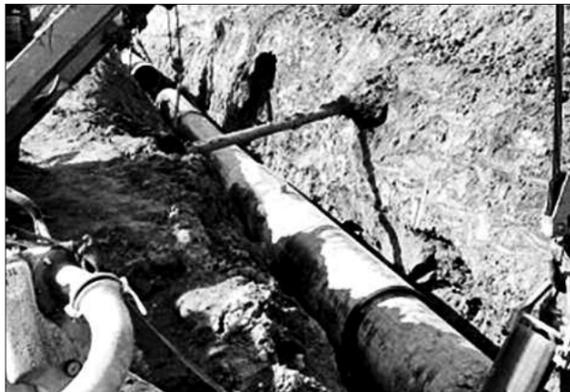
in due punti dove le acque hanno eroso il fondo sino a provocare una progressiva riduzione dello strato di copertura della condotta. I tubi esistenti saranno dismessi e il nuovo metanodotto sarà costruito su di un nuovo tracciato.
