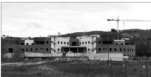
Una vista, aggiornata, del cantiere dell'Ospedale della Valle Belbo di regione Boidi a Nizza Monferrato.
