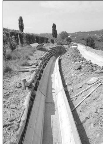
l'impermeabilizzazione del fosso, mediante canaletta in legno; verrà rifatto l'attraversamento stradale, con una tubazione in acciaio. Si procederà infine all'asfaltatura e alla risagomatura del tratto riparato.
