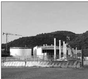
Il biodigestore di Ferrania in corso di realizzazione.
