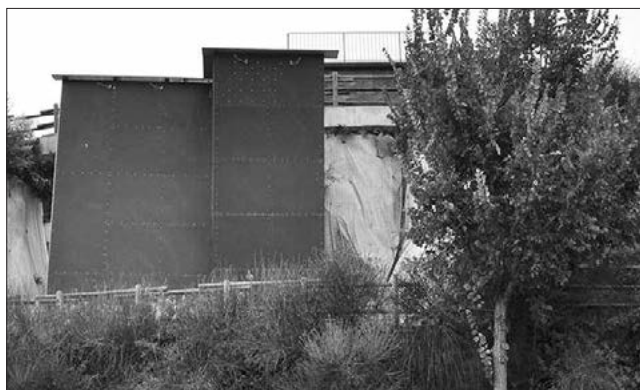
La parete in allestimento.
