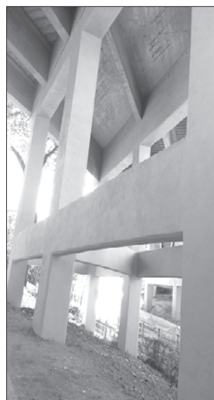
... e dopo il ripristino.
