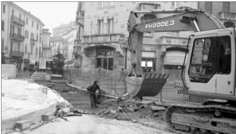
**Acqui Terme.** È in fase operativa la ristrutturazione della pavimentazione situata in piazza Italia intorno alla Fontana delle ninfe. Cubetti di porfido verranno sistemati al posto del lastricato. Da lunedì inizierà anche l'opera per la sistemazione definitiva delle lastre di granito situate ai lati delle trentadue vasche di marmo di corso Viganò.
