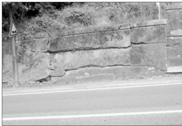
**Ovada.** Nella foto lo stato attuale del muro di sostegno lungo il lato di sinistra di via Molare, subito dopo il sottopasso ferroviario. Lungo il muro sono evidenti crepe rilevanti e notevoli sbreccature, anche dopo l'incrocio per via Vecchia Costa. Il fatto ci è stato segnalato da cittadini residenti in zona e, anche se la situazione non pare drammatica, forse val la pena di fare un sopralluogo tecnico per stabilire il da farsi.
