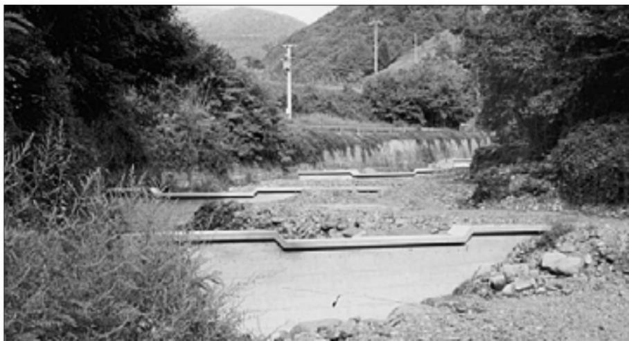
**Campo Ligure.** Continuano i lavori di sistemazione dell'alveo del torrente Angassino, a monte della diga, al fine di rinforzare il muro di sostegno della strada, che appariva abbondantemente scalfato, e di evitare eventuali crolli in sponda sinistra sorreggendola con una
